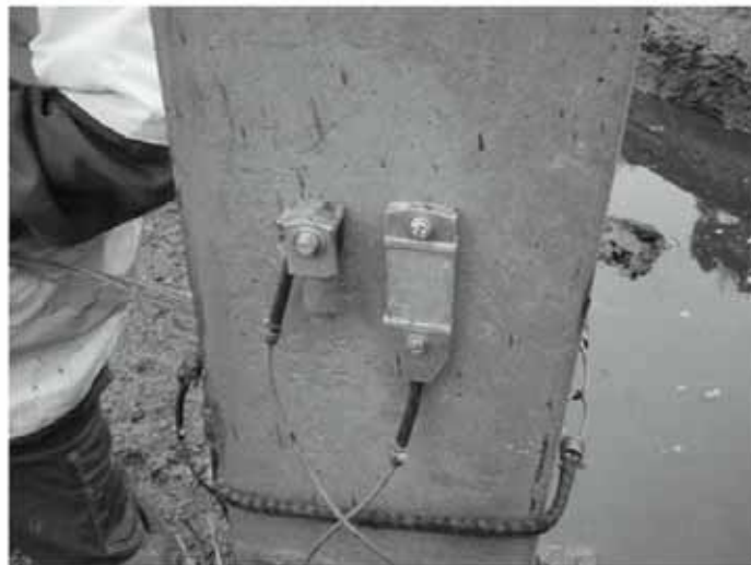
Figur 2.5 Accelerometer(tv) och töjningsgivare(th) vid stötvågsmätning
