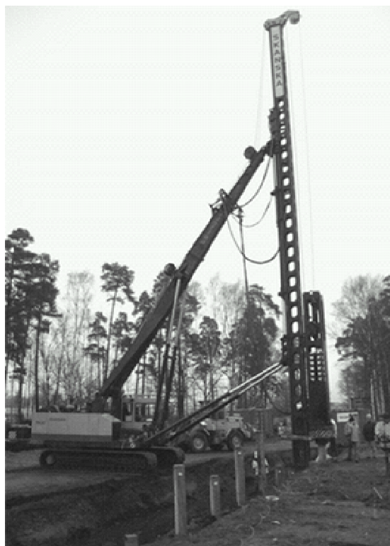
Figur 2.1. Pålkranen Junttan i aktion
